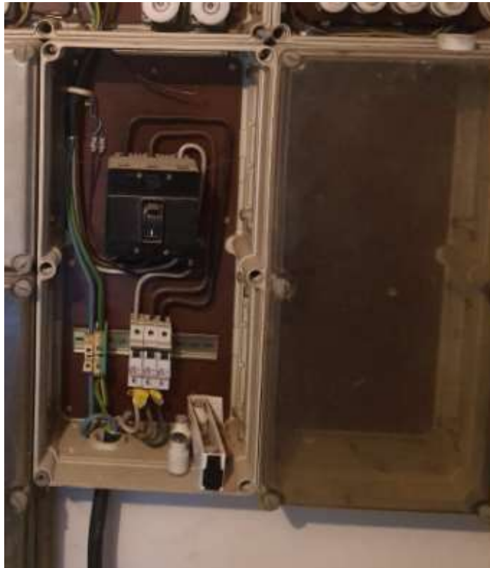
Slika 2 Mjesto spoja fotonaponske elektrane na NN mrežu
